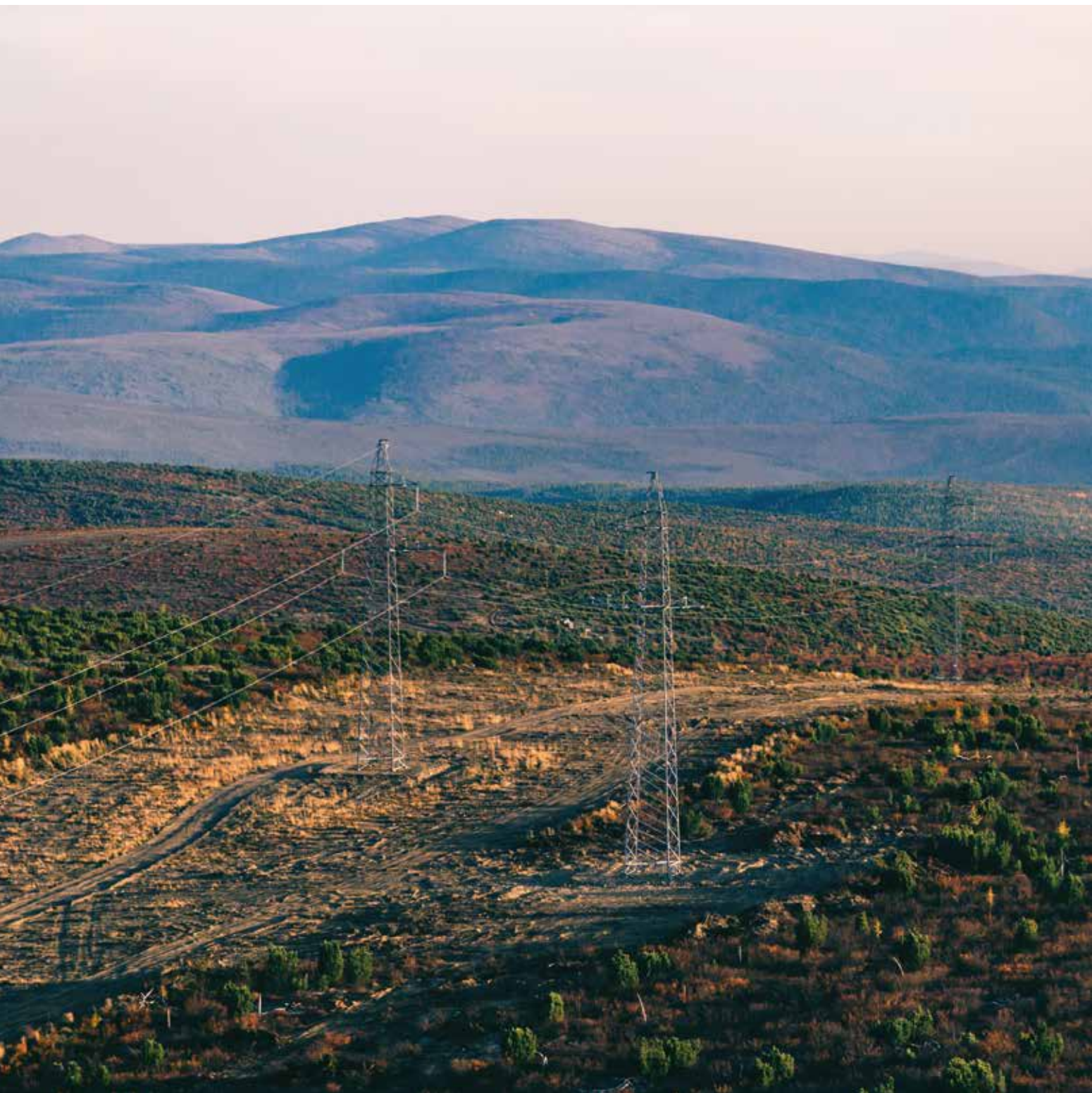
Воздушная линия 220 кВ Пеледуй — Сухой Лог, Иркутская область
