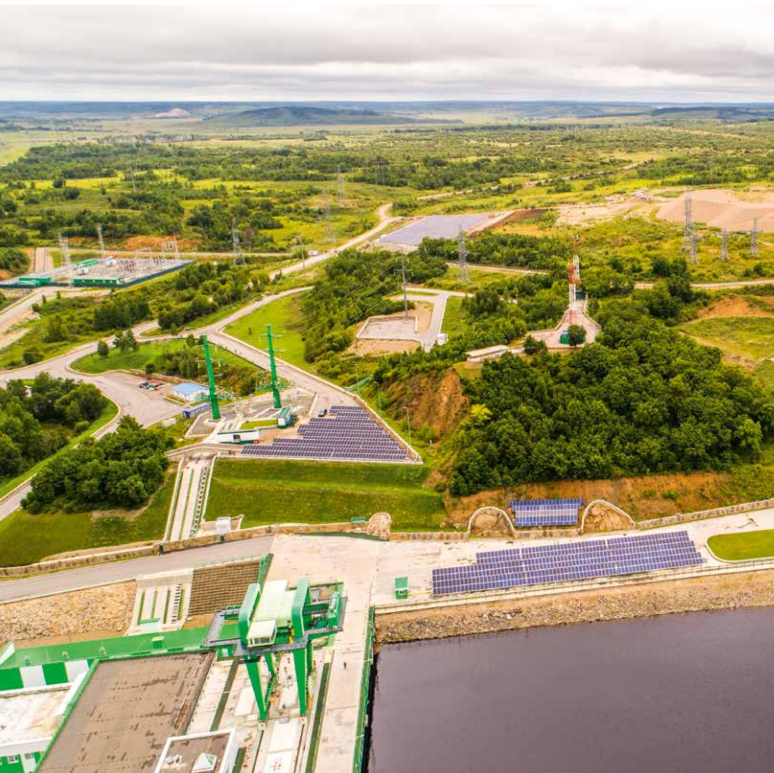
Солнечные электростанции на площадке Нижне-Бурейской ГЭС, Амурская область
