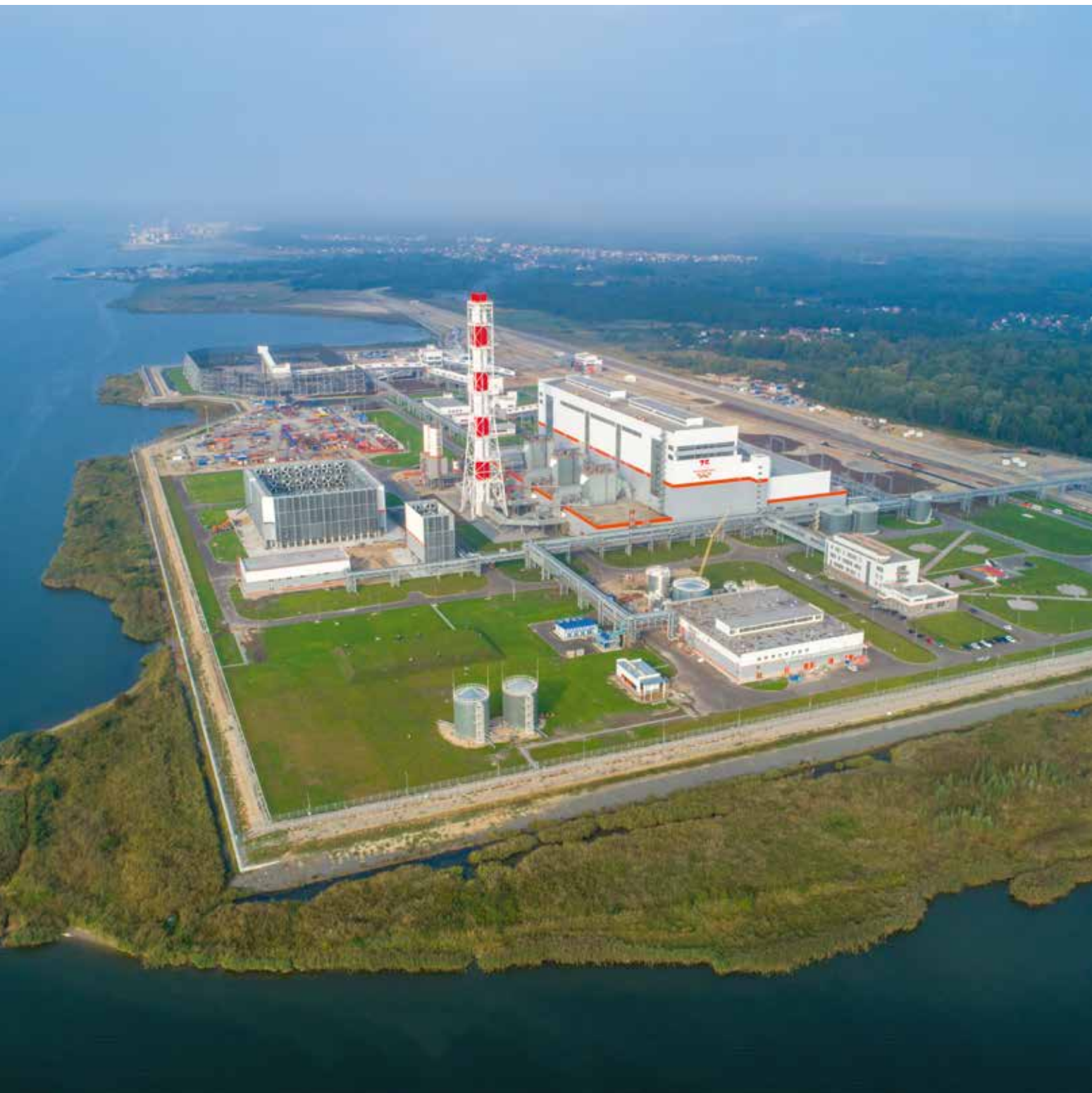
Приморская ТЭС, Калининградская область
