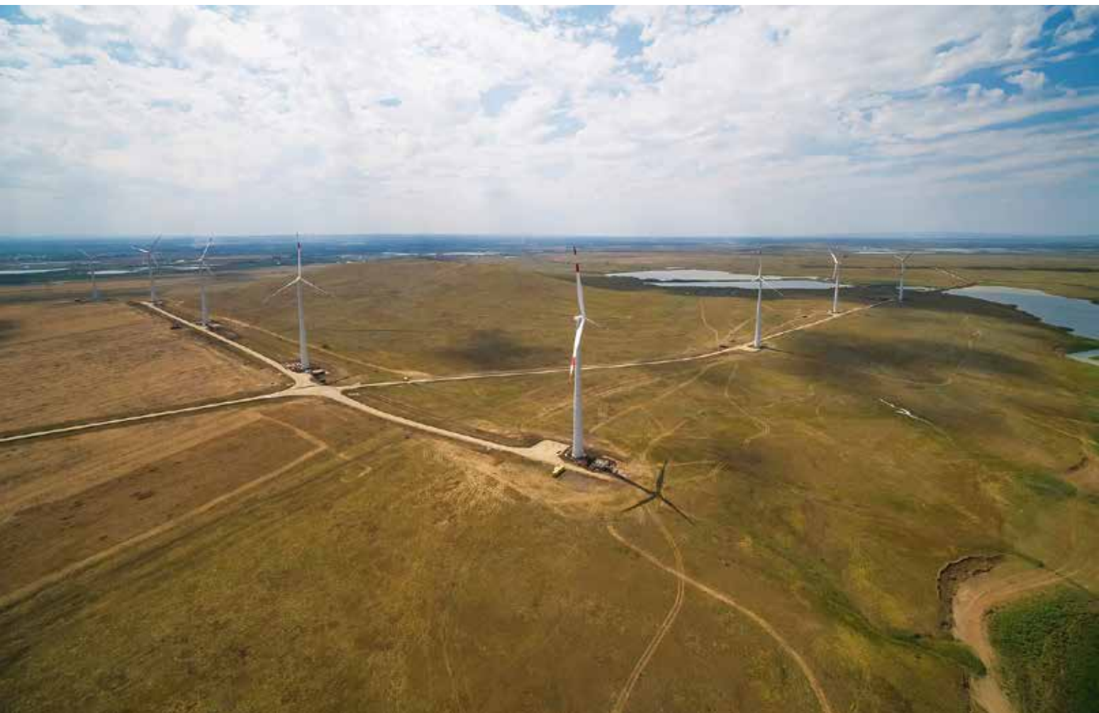
Кочубеевская ветроэлектростанция, Ставропольский край
